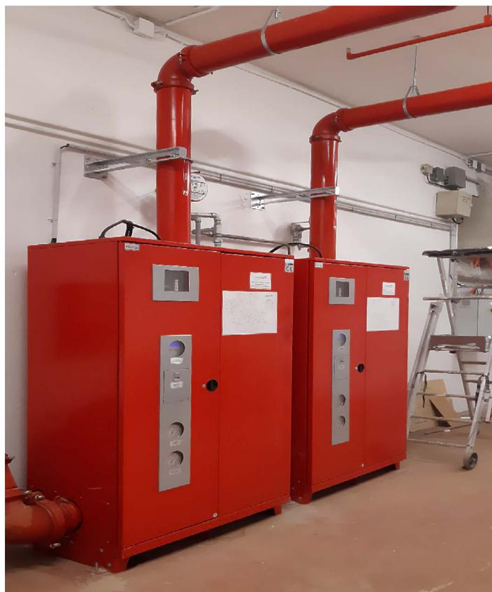
Fig. 4 : Une installation de sprinklage équipée d'une unité de commutation et de commande sous vide.
