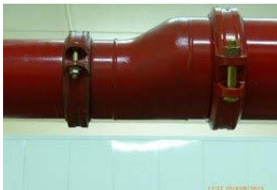
Fig. 13 et 14 : Réductions excentriques (Source : VacTec)
